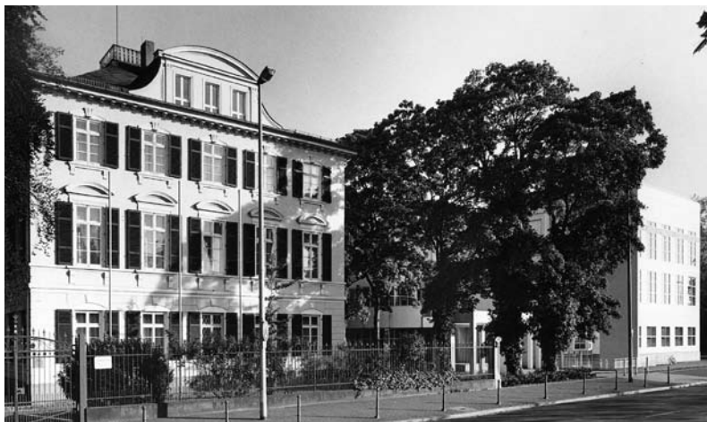
1989, die Villa mit dem neuen Gebäudekomplex von Richard Meier
