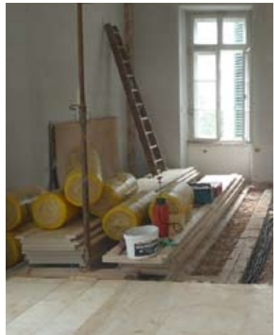
Bodenbauarbeiten im Barocksaal
