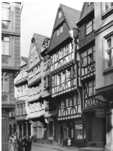
Alter Markt mit Haus Dracheneck, von den beiden freigelegten Fachwerkhäusern das etwas zurückliegende rechte, Foto um 1940
