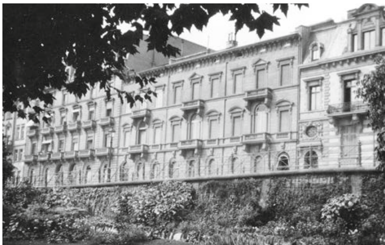
Haus Grunelius, Untermainkai 26, Mitte links, im Zusammenhang mit den baugleichen Reihenhäusern 25 und 24, Foto um 1930
