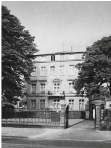
Haus Metzler-Lutteroth als aufgestocktes Bankhaus Kirchholtes (Foto: Uwe Dettmar, aus: Lerner, Bestand im Wandel, S. 161)
