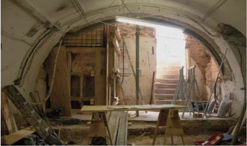
Bauarbeiten im Untergeschoss
