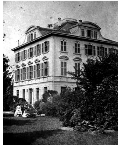
Die „Villa Metzler“ Schaumainkai 15 nach ihrem Umbau um 1864
