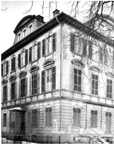
ca. 1963 war die Villa gerade dem Abriss entgangen
